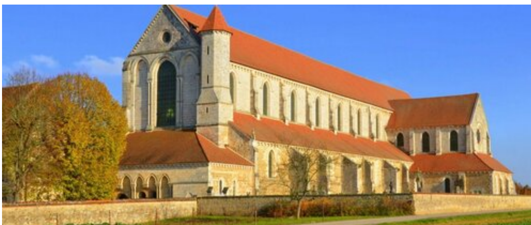
L'abbatiale de Pontigny rénovée
