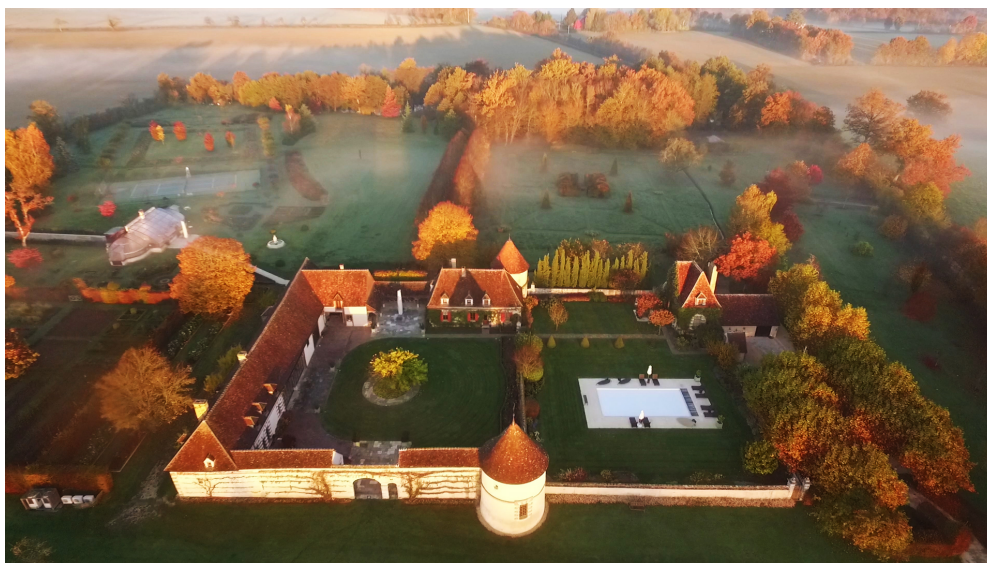
Château de La Borde, restauré, à Leugny
